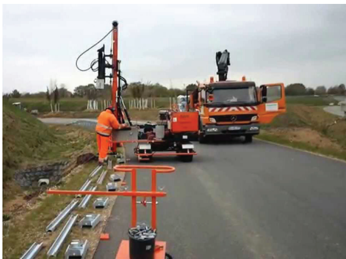
Набиване на мантинели в пътно строителство
